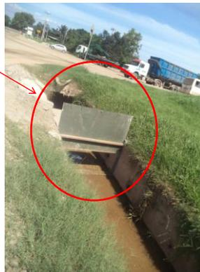
Comporta instalada no Canal após a elevatória.
